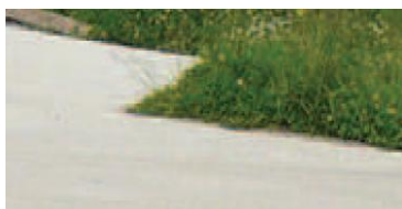
Figure 1 : Revêtement de sol en dalle béton
