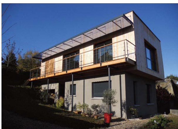
Figure 6 : Exemple d'utilisation du brise soleil
