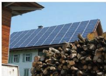
intégration de panneaux solaires
