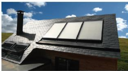
intégration de panneaux solaires pour chauffe eau solaire
