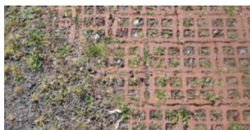
Figure 2 : Revêtement de sol en brique rouge
