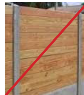
Lames bois sur soubassements maçonnés
