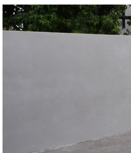
Élévations parpaing enduits hauteur inférieure à 1m00
