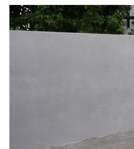
Élévations parpaing enduits hauteur inférieure à 1m00
