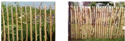
Il est possible d'intégrer dans la continuité de la clôture un portillon de type ganivelle d'une hauteur de 1,50 m. Dans la zone de construction, cette clôture peut être interrompue par le bâti de la construction.
